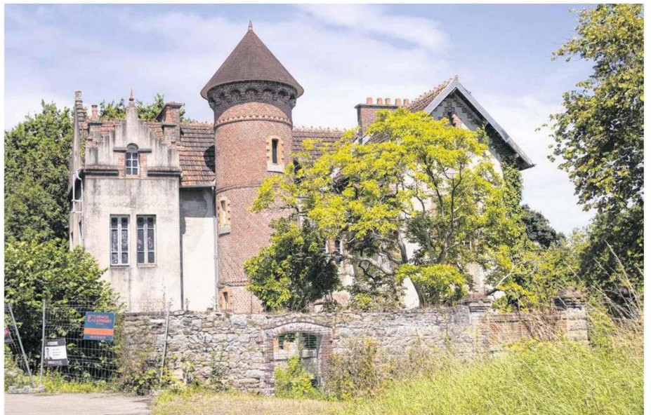
LANGUEUX. La Maison de l'Administrateur de la société des Tuileries et Briqueteries de Saint-Ilan ressemble, selon Maryse Stourm, au « château de la belle au bois dormant ». Anne-Sophie Matrat
